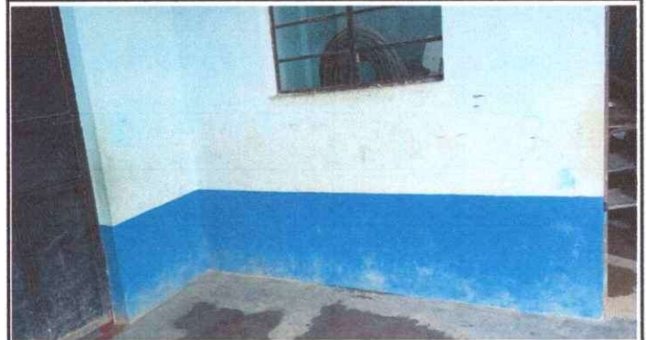
Foto 8: Mejoramiento de pintura en paredes tanto interior como exterior, debido al desgaste y suciedad.
