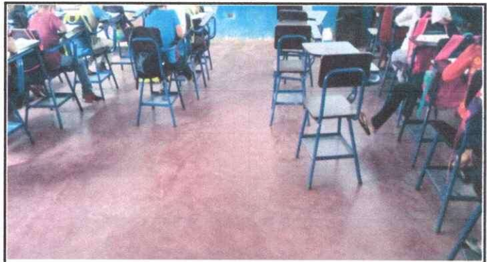
Foto 4: Sustitución de torta de concreto en mal estado y desgastado por piso ceramico.
