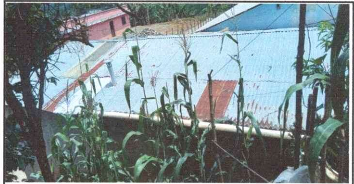
Foto 2: Sustitución por lámina troquelada en modulos de segundo primaria, cocina y bodega.
