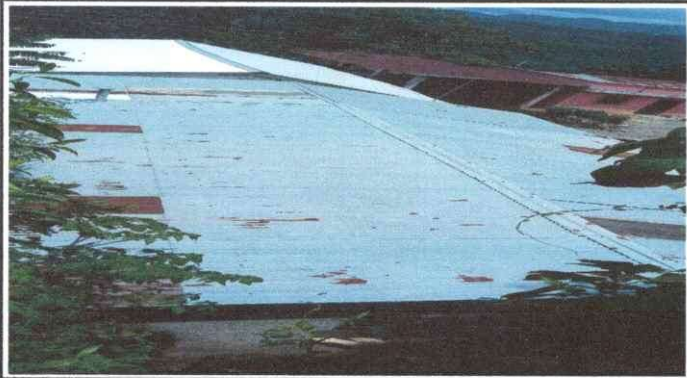
Foto 1: Sustitución de lámina acanalada en mal estado por lamina troquelada.
