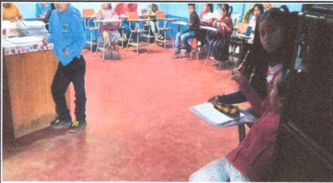
Foto 3: Sustitución de torta de concreto en mal estado y desgastado por piso ceramico.
