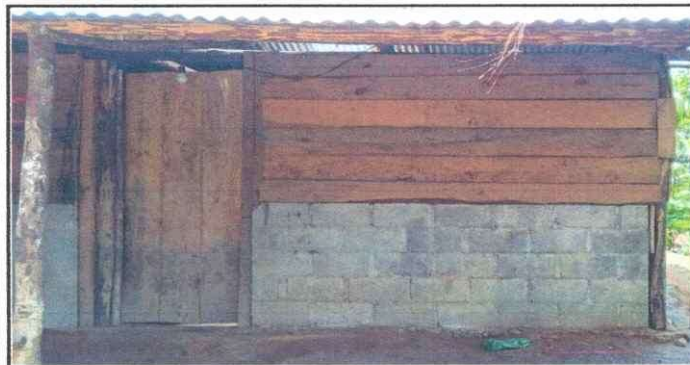
Foto 11: Mejoramiento de pared de madera por block.
