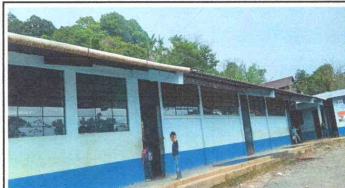
Foto 9: Instalación de canales y tubería para mejorar la captación de agua pluvial.
