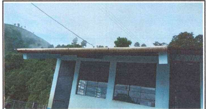
Foto 10: Instalación de canales y tubería para mejorar la captación de agua pluvial.
