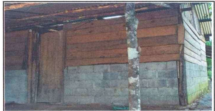
Foto 12: Mejoramiento de estructura de madera por metal y cubierta de lamina.
