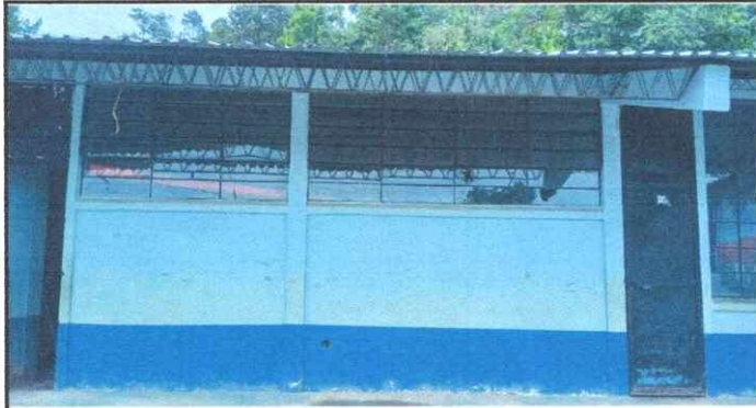
Foto 7: Mejoramiento de pintura en paredes tanto interior como exterior, debido al desgaste y suciedad.
